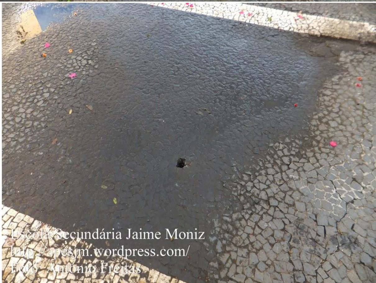
Drenagem de pontos de acumulação de água
