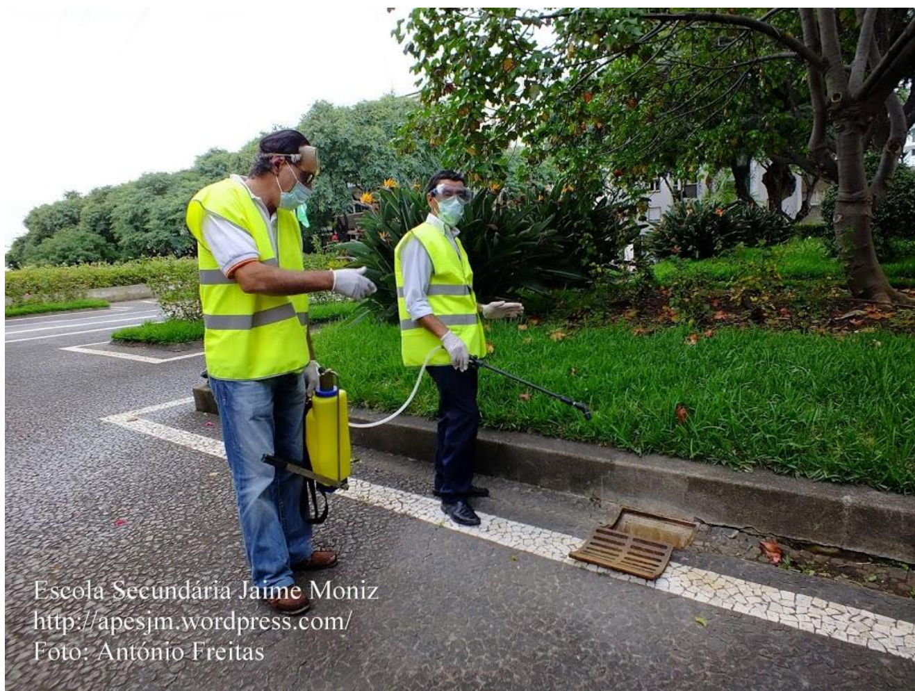
Desinfeção das sargetas
