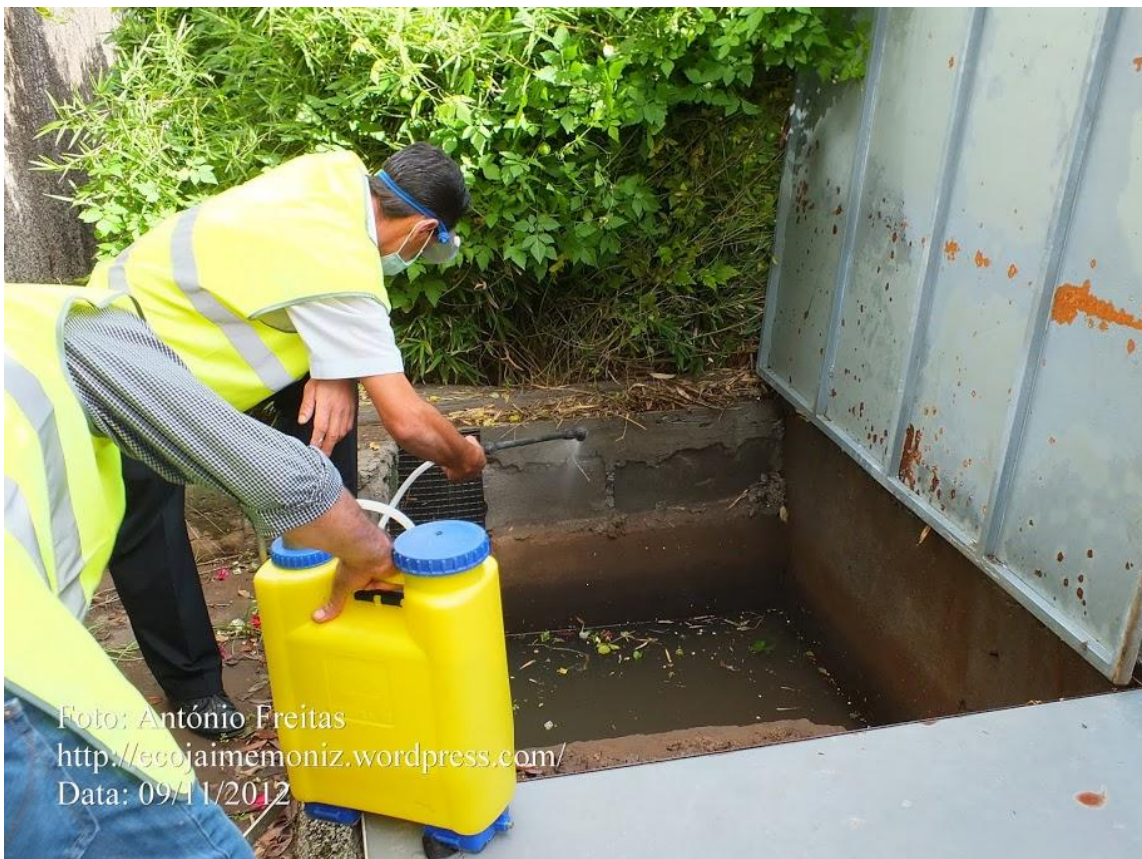
Desinfecção e isolamento da entrada de água no poço de rega do campo de futebol
