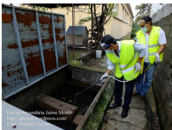
Desinfeção e isolamento da entrada de água no poço de rega do campo de futebol
