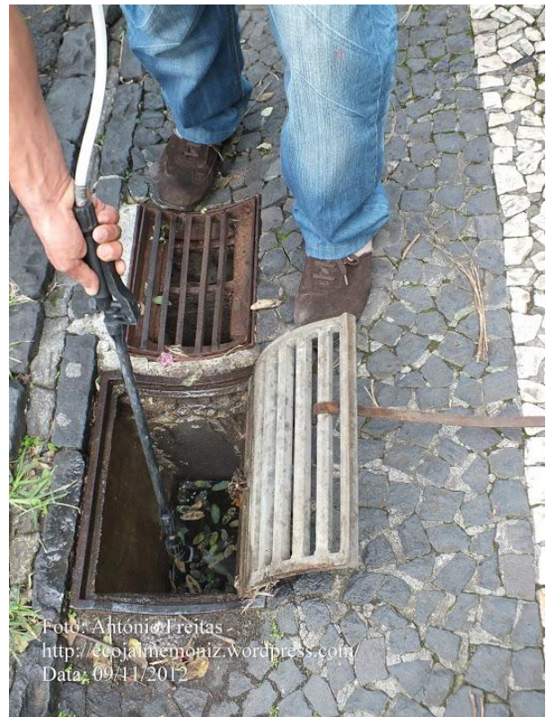
Desinfecção e isolamento da entrada de água no poço de rega do campo de futebol
