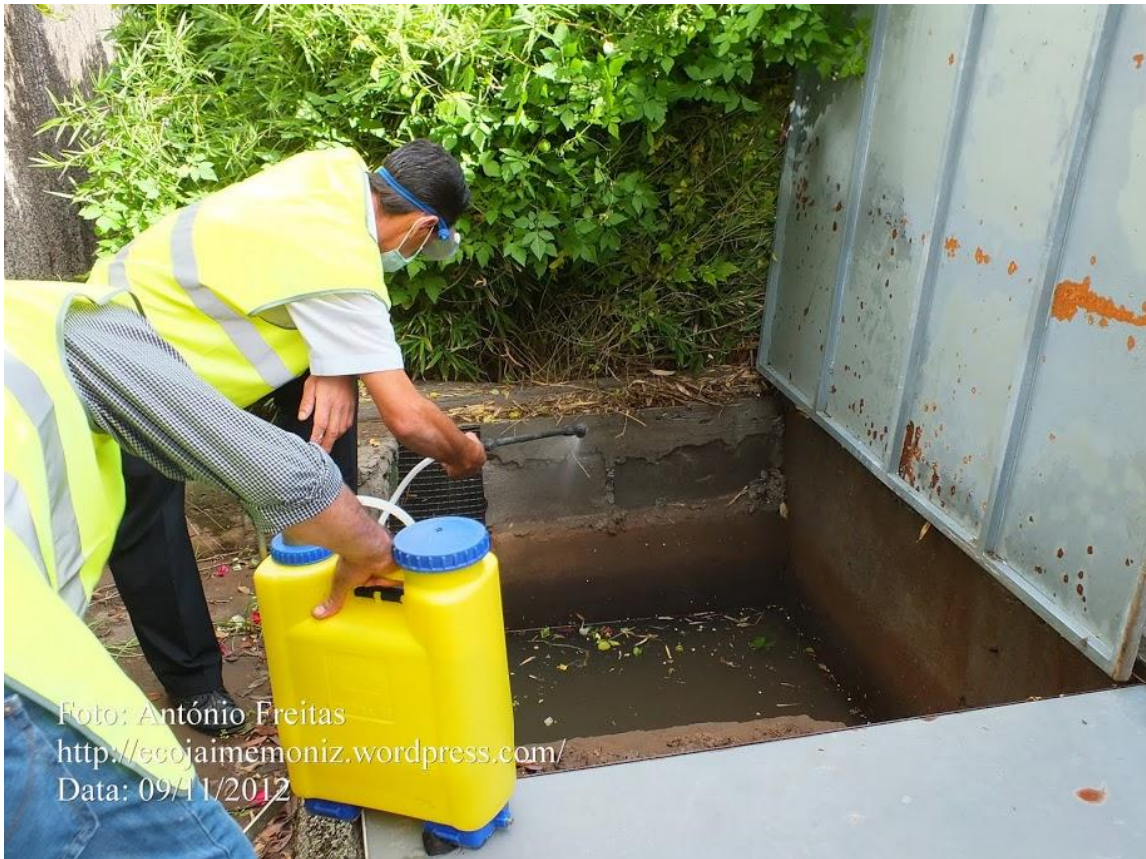
Desinfecção e isolamento da entrada de água no poço de rega do campo de futebol
